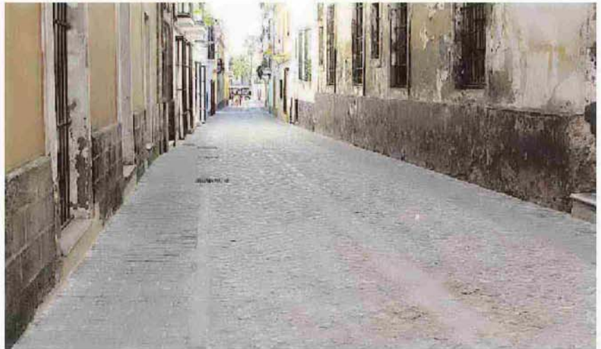
El estado actual de una de las calles tras ejecutarse las obras. :: LA VOZ
