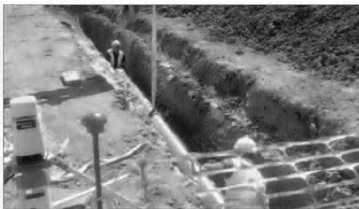
PROYECTO. Trabajos de construcción de la nueva red en El Condado.
