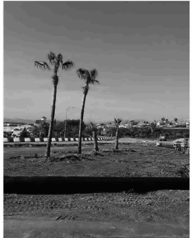
Obras para la construcción de la depuradora de Nerja.
