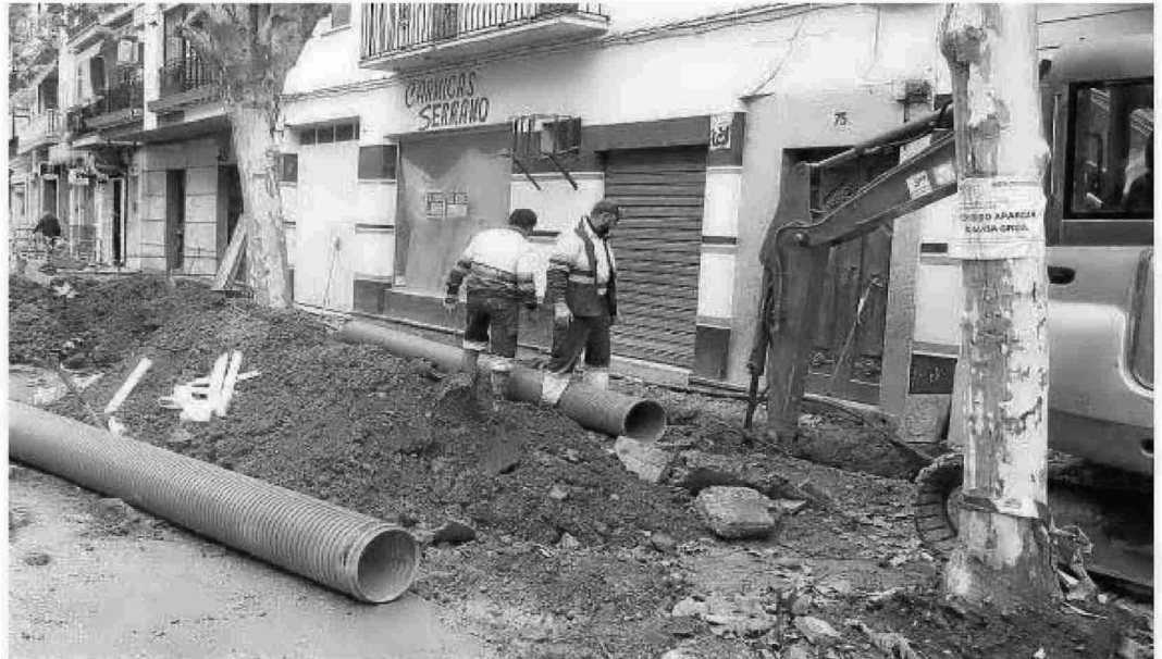
Empleados de Somajasa colocan unas tuberías en la Corredera de Capuchinos. :: J. C. GONZÁLEZ
