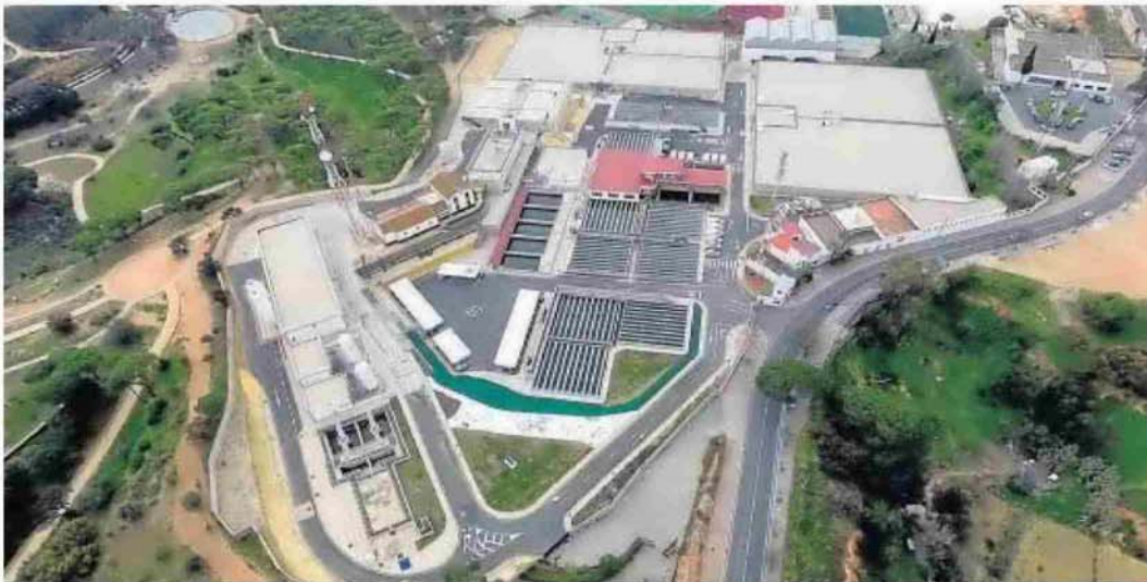
Vista aérea de las instalaciones de Aguas de Huelva en El Conquero, donde se aprecian los nuevos depósitos.
