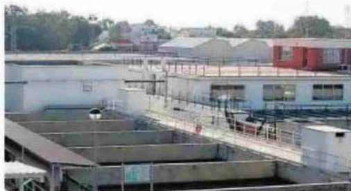
La planta potabilizadora, tras su ampliación.
