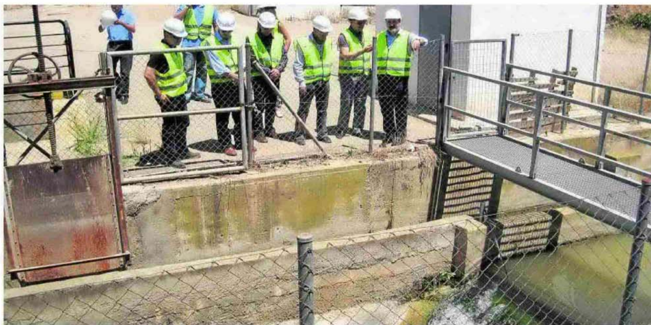
Ortiz y técnicos de las constructoras, en una visita a las arquetas de recepción del agua de los trasvases, en El Saltador, de Huércal-Overa. :: IDEAL
