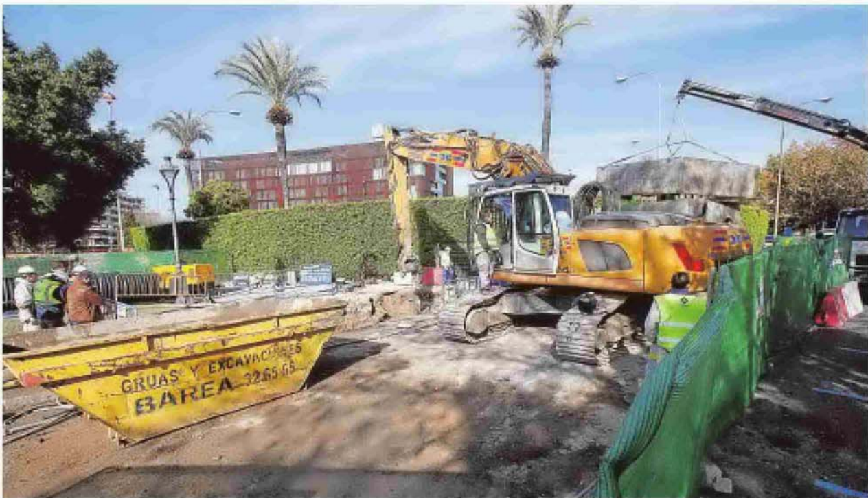
Operarios trabajan en el socavón de la calle Pintor López Obrero
