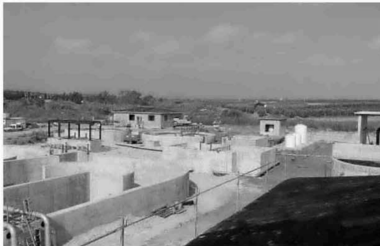
Instalaciones de la EDAR de Bollullos antes de su inauguración, en marzo del año pasado.
