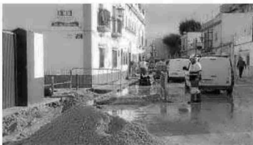
Operarios, ayer, mientras trabajan en la reparación de la tubería rota.
