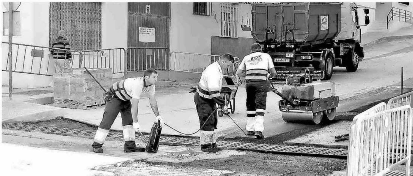
Operarios trabajan en el asfaltado de la carretera tras sustituir la alcantarilla. :: L.P.
