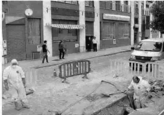
Varios operarios de Aguas de Huelva reparan la avería.
