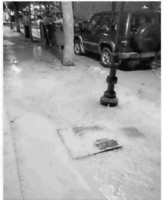
Un gran caudal de agua emanó a través de las baldosas.
