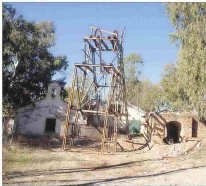
DEMANDA. Vista de la zona donde se encuentra la bomba de agua.
