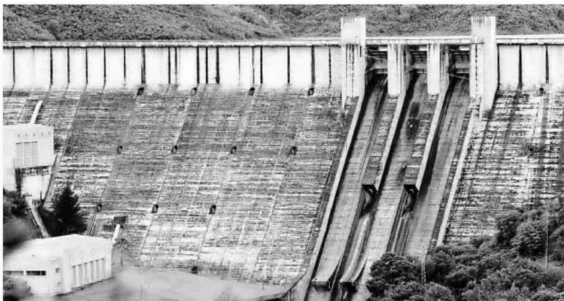
Presa de La Concepción que regula las aguas de río Verde.
