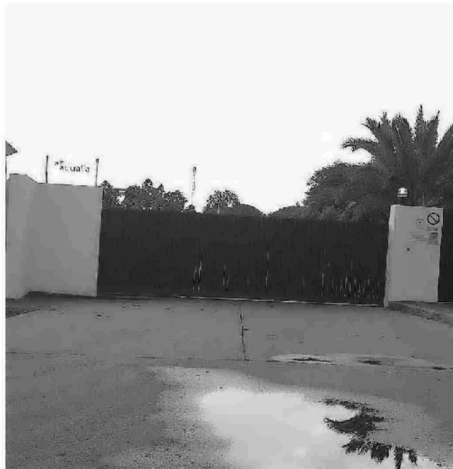
La depuradora Las Galeras, lugar de las supuestas irregularidades. ✪ P. H.
