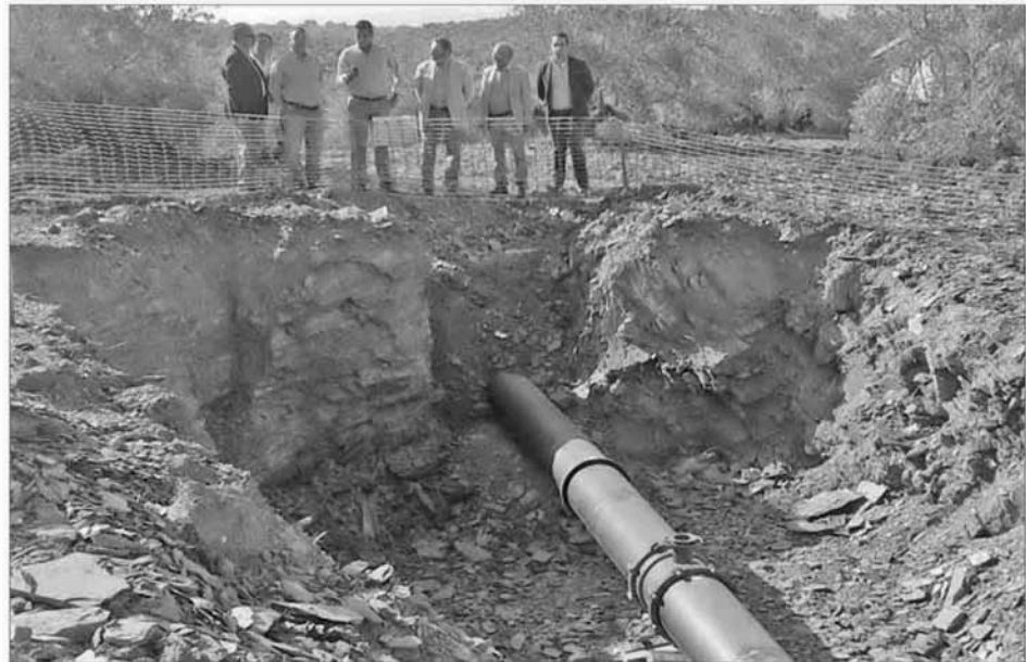
OBRAS. Lillo, junto con alcaldes de la comarca y técnicos de la Confederación, observan la tubería.
