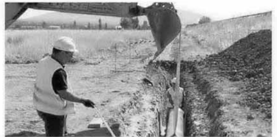
Trabajos en la red de abastecimiento del Condado. :: J. A. G. M.
