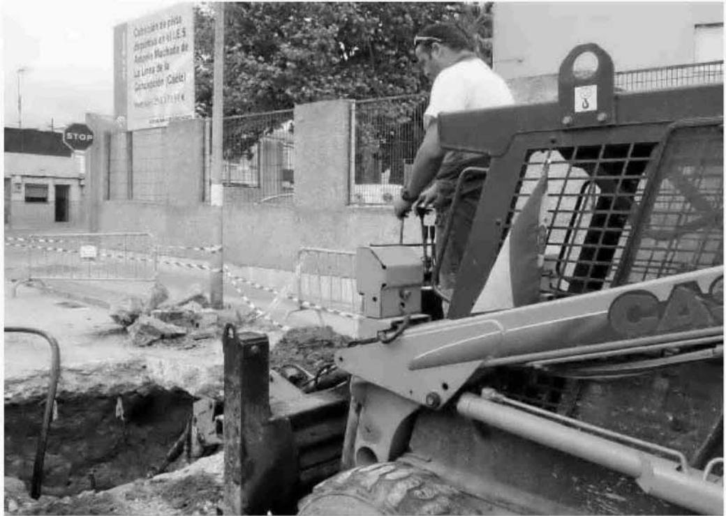
Imagen de trabajos de mantenimiento en la red de aguas por parte de Aqualia.
